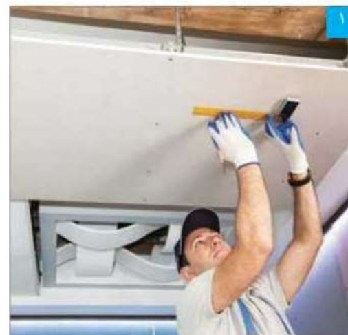
تعیین محل نصب دریچه و ترسیم ابعاد بر روی پتل
