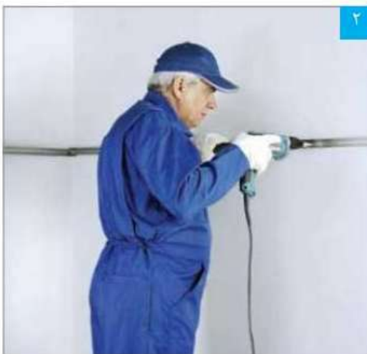
۲ نصب سازه تراز
