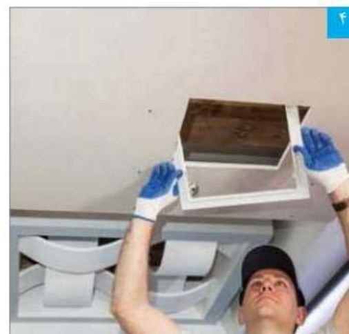
قرارگیری قاب پیرامونی دریچه
