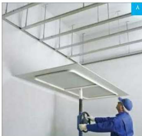
استقرار پتل با استفاده از بالابر
