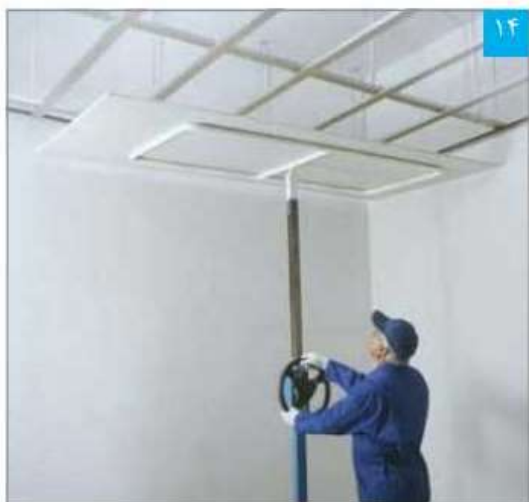
استقرار پنل با استفاده از بالابر
