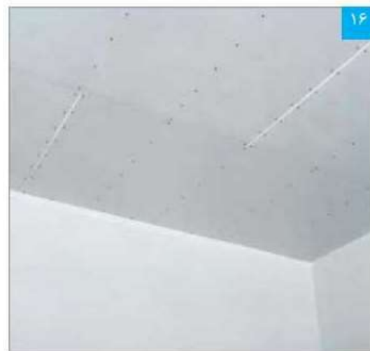
پنل گذاری تکمیل شده (به صورت حصیرچین)
