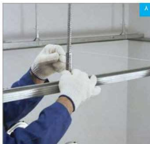
اتصال رکاب به آویز و رگلاژ سقف توسط پین
