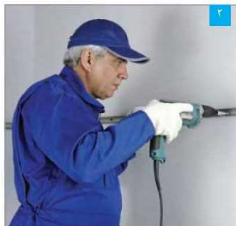
نصب سازه تراز
