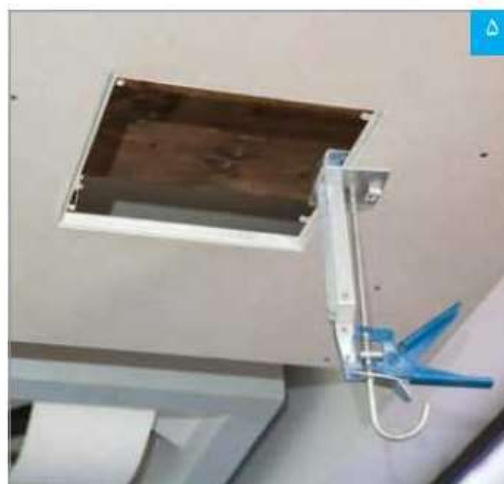
تنظیم و ثابت کردن محل نصب دریچه
