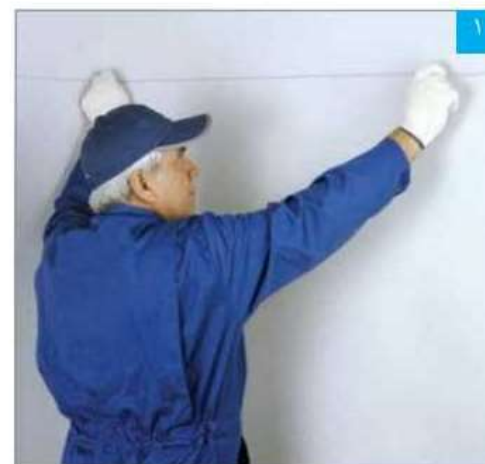
مشخص کردن محل نصب سازه تراز یا ریسمان رنگی
