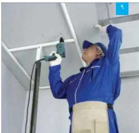
اتصال پتل به زیرسازی توسط پیچ
