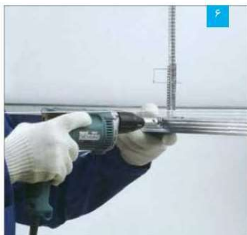
اتصال سازه باربر به چنگک توسط پیچ LN
