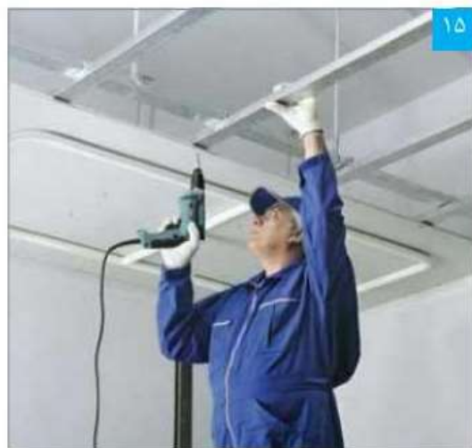
اتصال پنل به زیرسازی توسط پیچ
