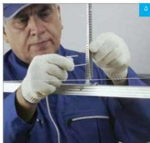
اتصال چنگک به آویز و رگلاژ سقف توسط پین
