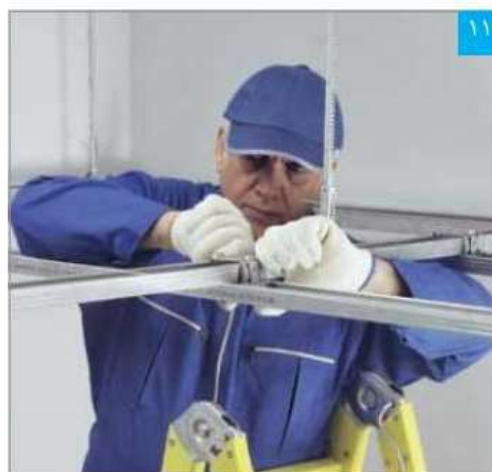
اتصال سازه پنل خور به سازه باربر توسط قطعه اتصال کامل
