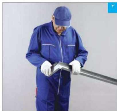
پس از برش بال‌ها، رانر خم و راست شده تا از محل جان برش بخورد
