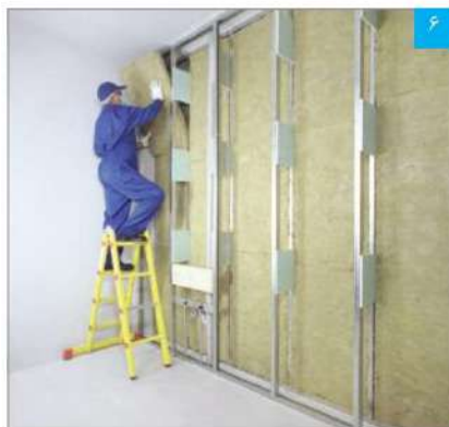
اجرای عایق پشم معدنی (پس از اجرای تاسیسات)
