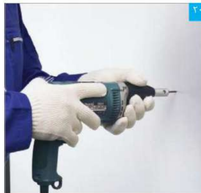
نحوه صحیح در دست گرفتن پیچ زن (به صورت عمود بر پنل)
