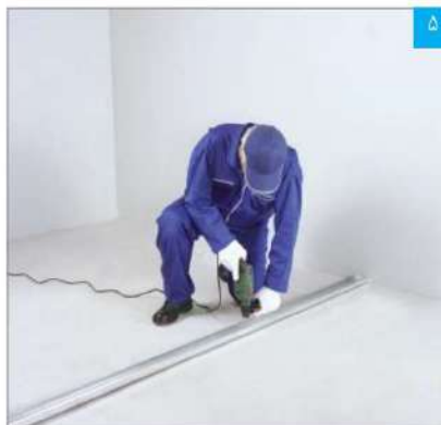
نصب رانر کف (سوراخ کردن رانر و کف)
