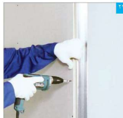
پنل باید در جهتی نصب شود که لبه آزاد آن به سمت دهانه باز استناد قرار گیرد
