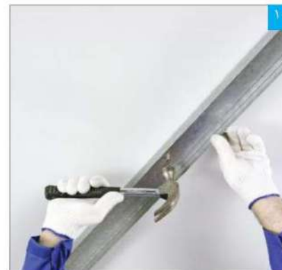
اتصال رانر به سقف با رول پلاگ
