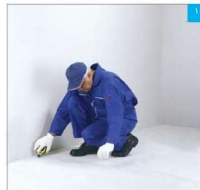
مشخص کردن محل نصب رانر کف یا ریسمان رنگی
