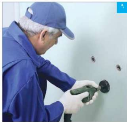
خروجی‌های تاسیساتی به وسیله گردبر ایجاد می‌شوند
