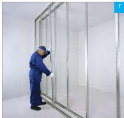
اجرای ردیف دوم استاداها
