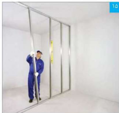
۱۵ اجرای استاداها (به صورت شاقولی)
