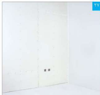
دیوار تکمیل شده (خروجی‌های تاسیساتی به وسیله گردپر یا اره چاقویی و سوهان ایجاد می‌شوند)
