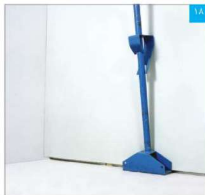
۱۸ پنل ها پوسيله چك مخصوص به نحوی بر روی زیرسازی قرار می گیرند که ۱ سانتی متر با کف فاصله داشته باشند
