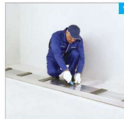
برش نوارهای عایق
