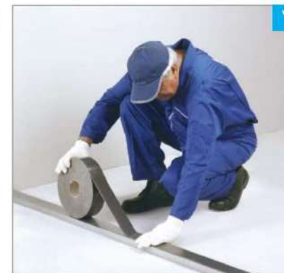
اجرای نوار عایق (پا دو ردیف خمیر سیلیکون) بر پشت جان رانر کف و سقف
