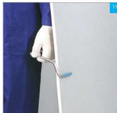
۱۷ حمل پنل به سادگی با گیره مخصوص و توسط دو نفر انجام می شود
