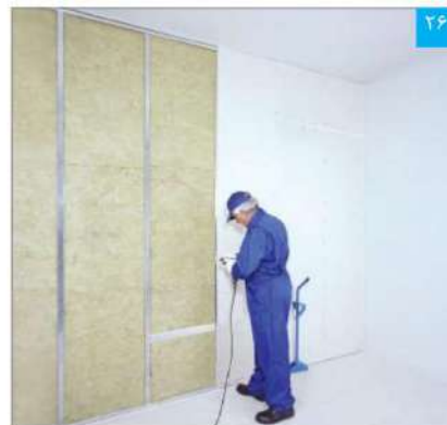
اجرای پنل‌ها در طرف دیگر دیوار (پنل‌ها نسبت به سمت اول به صورت حصیرچین اجرا می‌شوند)
