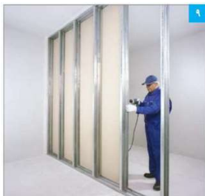
اجرای پنل‌ها در یک طرف دیوار
