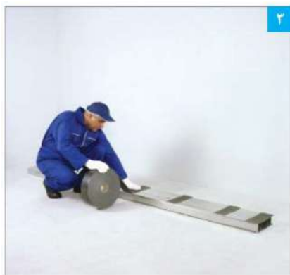
اجرای نوار عایق بر روی استاداها
