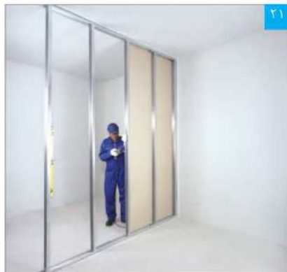
اجرای پنل‌ها در یک طرف دیوار
