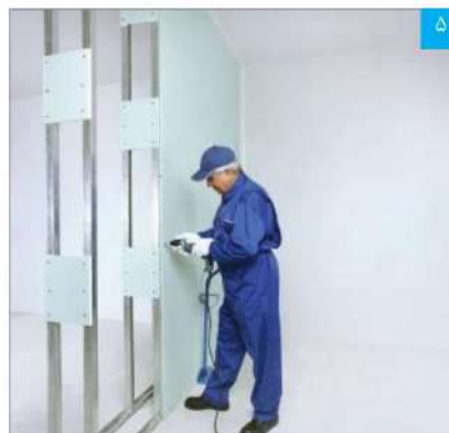
اجرای پنلها در یک طرف دیوار
