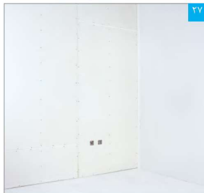
دیوار تکمیل شده (خروجی‌های تاسیساتی به وسیله گردبیر یا اره چاقویی و سوهان ایجاد می‌شوند)
