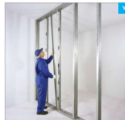
۷ اجرای ردیف دوم استاداها
