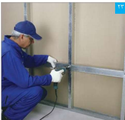
۲۳ اجرای سازه پشت بند در محل درز افقی
