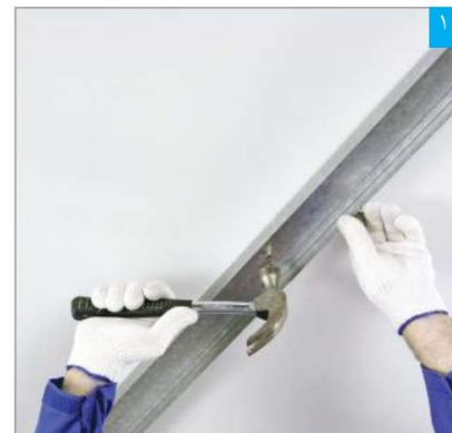
اتصال رانر به سقف با رول پلاگ
