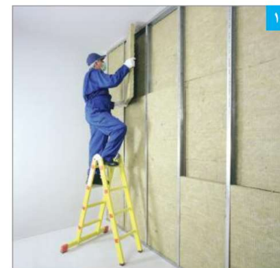
۱۰ اجرای عایق پشم معدنی (بسته به نظر طراح، لایه عایق می‌تواند در یک یا دو ردیف اجرا شود)
