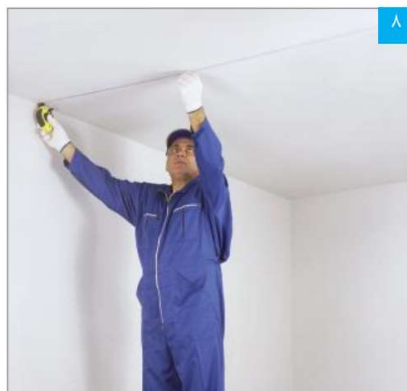
مشخص کردن محل نصب رانر سقف با ریسمان رنگی
