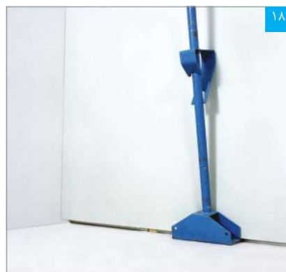
۱۸ پنل‌ها بوسیله جک مخصوص به نحوی بر روی زیرسازی قرار می‌گیرند که ۱ سانتی‌متر با کف فاصله داشته باشند
