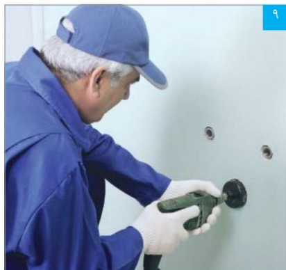
خروجی‌های تاسیساتی به وسیله گردبر ایجاد می‌شوند
