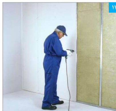
۱۱ اجرای پنل‌ها در طرف دیگر دیوار (پنل‌ها نسبت به سمت اول به صورت حصیر چین اجرا می‌شوند)
