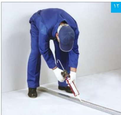
اجرای دو ردیف خمیر سیلیکون (یا نوار عایق) بر پشت جان استادهای جانبی
