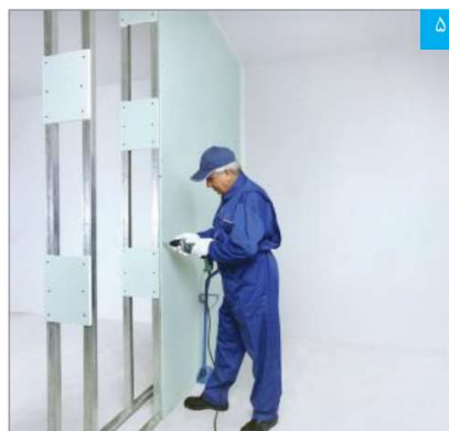
اجرای پنلها در یک طرف دیوار
