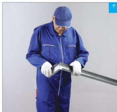
۳ پس از برش بال‌ها، رانر ختم و راست شده تا از محل جان برش بخورد
