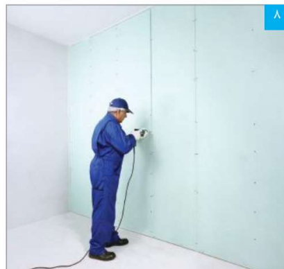
اجرای لایه دوم پنل‌ها (لایه دوم نسبت به لایه اول به صورت حصیرچین اجرا می‌شود)
