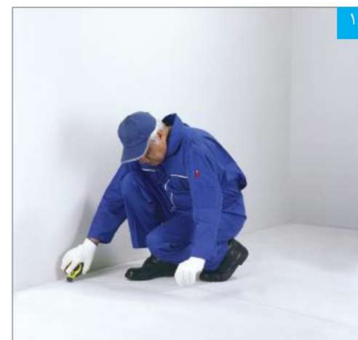
۱ مشخص کردن محل نصب رانر کف با ریسمان رنگی
