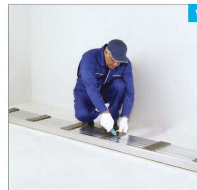
برش نوارهای عایق
