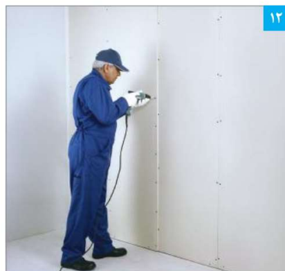
۱۲ اجرای لایه دوم پنل‌ها (لایه دوم نسبت به لایه اول به صورت حصیر چین اجرا می‌شود)
