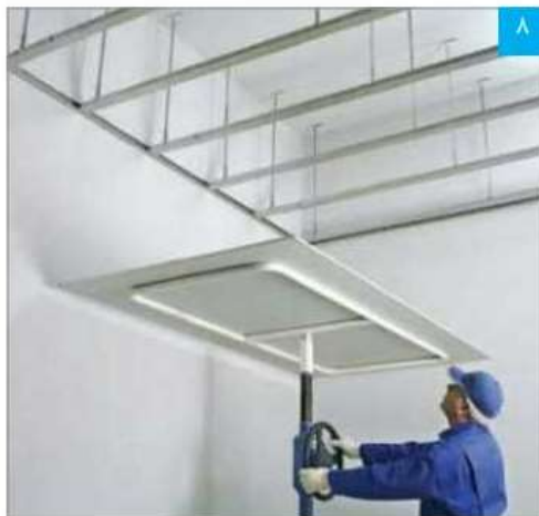
استقرار پتل با استفاده از بالابر
