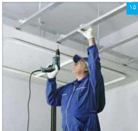
اتصال پنل به زیرسازی توسط پیچ
