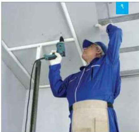
اتصال پتل به زیرسازی توسط پیچ
