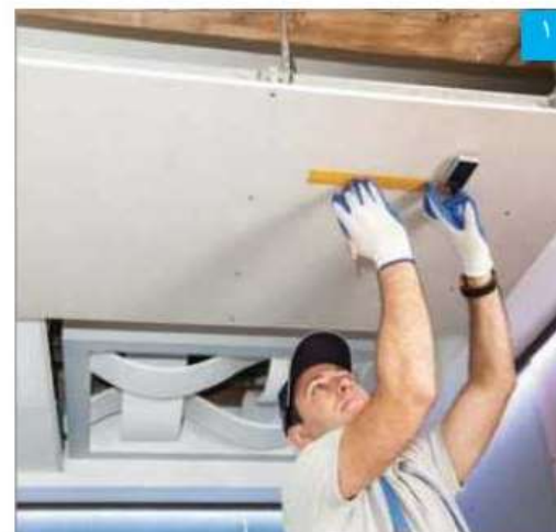
تعیین محل نصب دریچه و ترسیم ابعاد بر روی پینل
