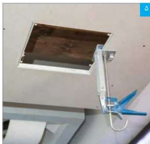
تنظیم و ثابت کردن محل نصب دریچه
