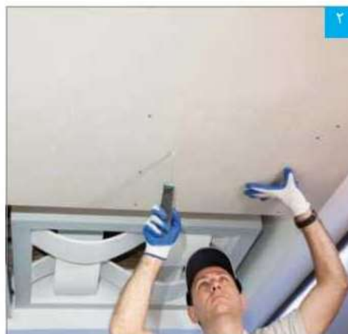
برش کاری محل نصب دریچه (جهت سهولت نصب هر وجه ۵ میلی متر بزرگتر برش داده شود)
