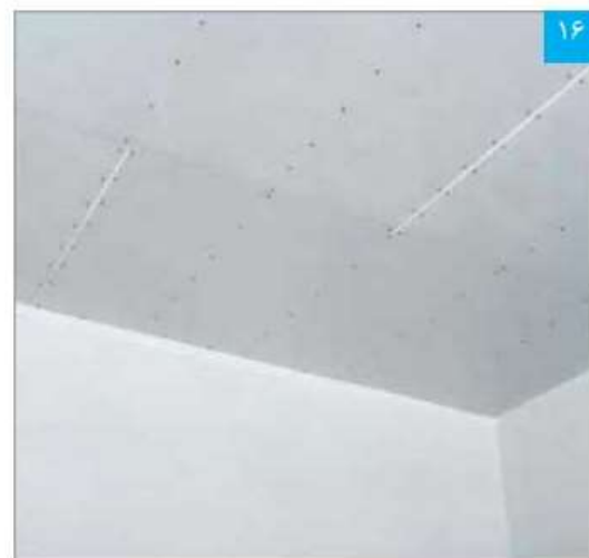
پنل گذاری تکمیل شده (به صورت حصیرچین)
