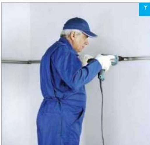
۲ نصب سازه تراز
