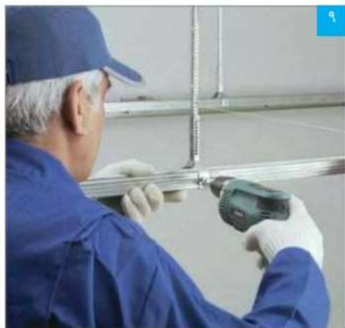
اتصال سازه باربر به رکاب توسط پیچ LN
