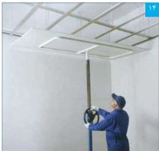
استقرار پنل با استفاده از بالابر
