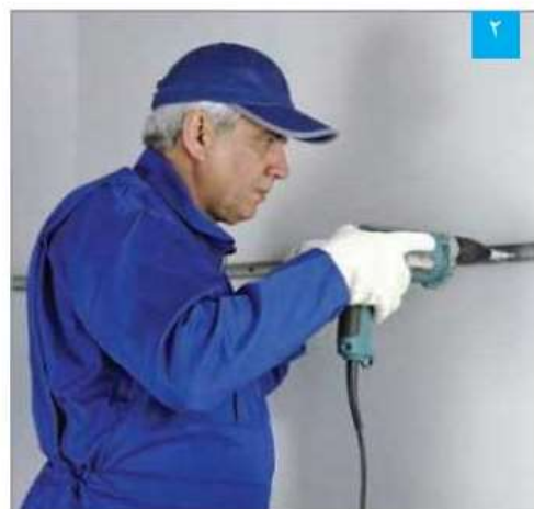
نصب سازه تراز
