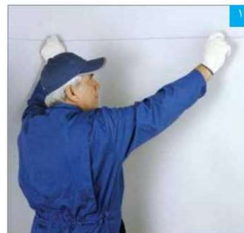
مشخص کردن محل نصب سازه تراز با ریسمان رنگی
