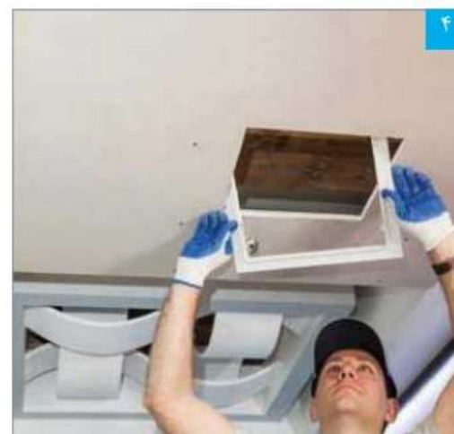
قرارگیری قاب پیرامونی دریچه
